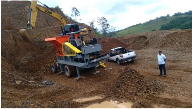
Prefeito Laerte acompanhou o início dos trabalhos do britador
